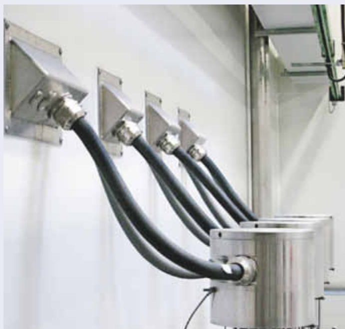
Reinraumwanddurchführung für Kabeldurchführungen aus Edelstahl
