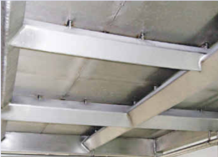
Edelstahlbühne: spaltfrei geschweißt mit optimaler Profilanordnung für Reinigung und Inspektion
